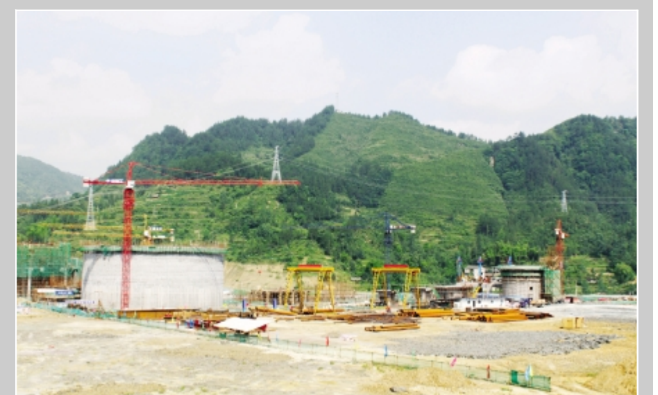
建设中的重庆正阳新材料有限公司工地一景 摄影/刘晓凤
