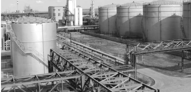
▲呼伦贝尔东能化工有限公司成立于2007年1月5日,是内蒙古呼伦贝尔市第一家正式开工建设的煤化工企业,公司规划可生产甲醇120万吨、二甲醚30万吨,并向下游高附加值产品延伸。
